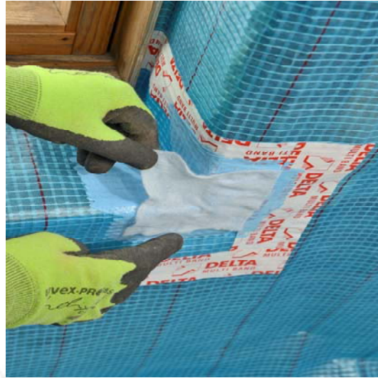
Pose du géotextile.
