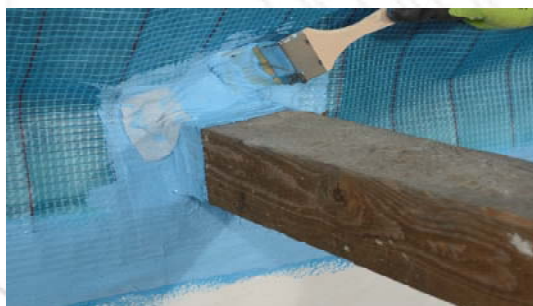
Seconde couche de pâte sur le géotextile.
