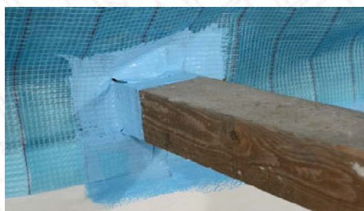
Pose de la couche d'accroche.
