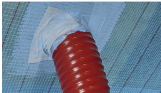
Pose du géotextile.
